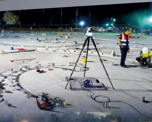
Einsatz der Flexijet 3D Projektionsfunktion zur exakten Positionierung von Verankerungen für Edelstahlplatten, die als Träger von beleuchteten Glasornamenten dienen. Um Bohrpunkte auf der Baustelle anzuzeichnen, wurden 14.000 Punkte einer CAD-Zeichnung mit dem Flexijet 3D Laseraufmaßsystem passgenau auf den Boden projiziert.
